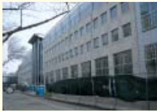
竣工間近のシカゴ大学 “Interdivisional Research Building”
